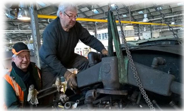
Démontage de la nourrice devant la cabine de conduite.
